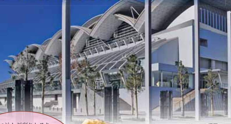
マリンメッセ福岡 写真提供:福岡市
